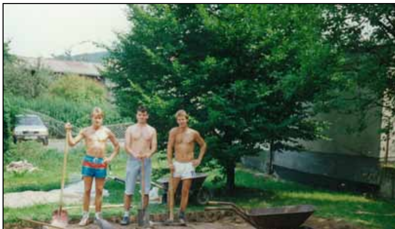
Uwe Neumann, Dietmar Görlinger und Uwe Gondermann beim Posing auf dem Fundament der Grillhütte.
