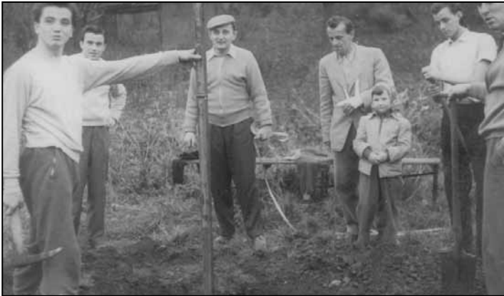
Bau des Kleinfeldes hinter der Jahntur- nalle
